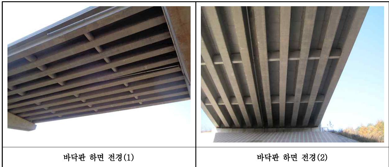
【사진 32.3.2】 바닥판하면 전경
