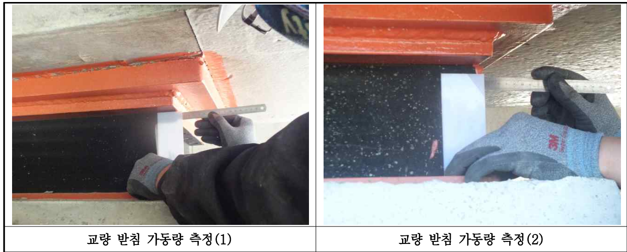
【사진 32.3.15】 교량받침 이동량 측정
