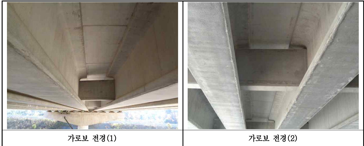
【사진 32.3.29】 가로보 전경
