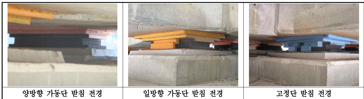
【사진 32.3.34】 교량받침 전경
