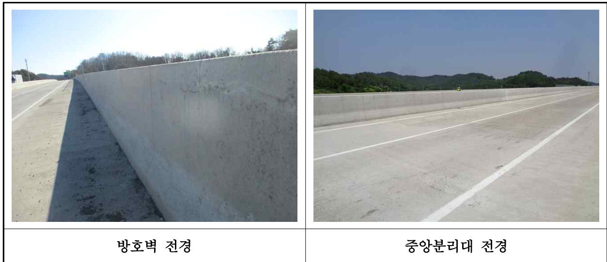
【사진 32.3.45】 방호벽 및 중앙분리대 전경
