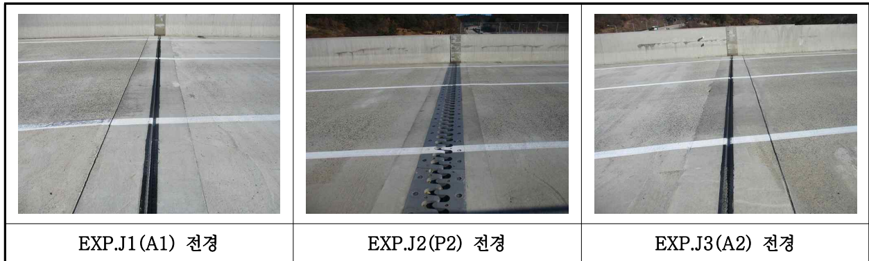
【사진 32.3.38】 신축이음장치 전경
