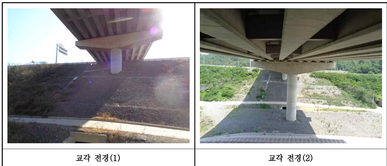
【사진 32.3.33】 교각 전경
