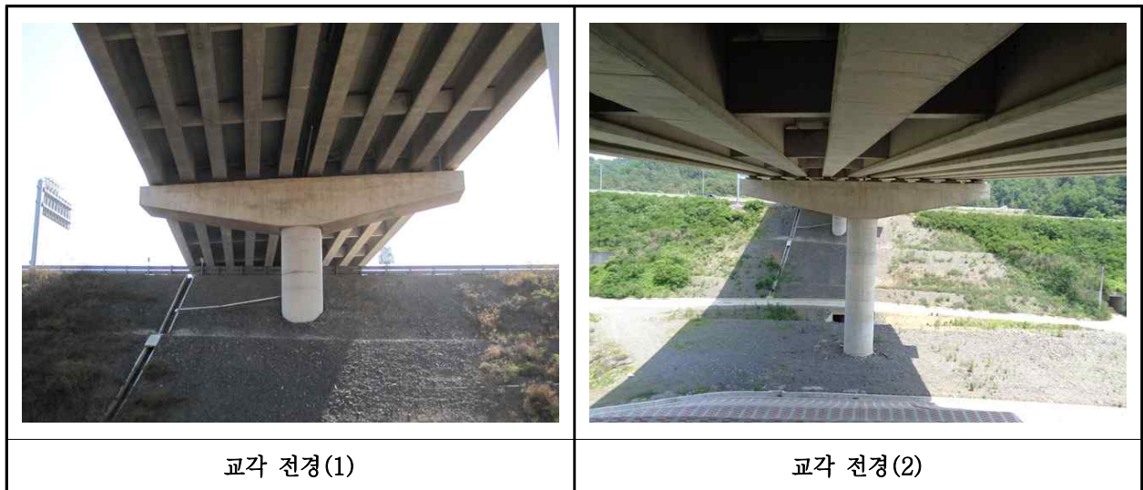
【사진 32.3.10】 교각 전경
