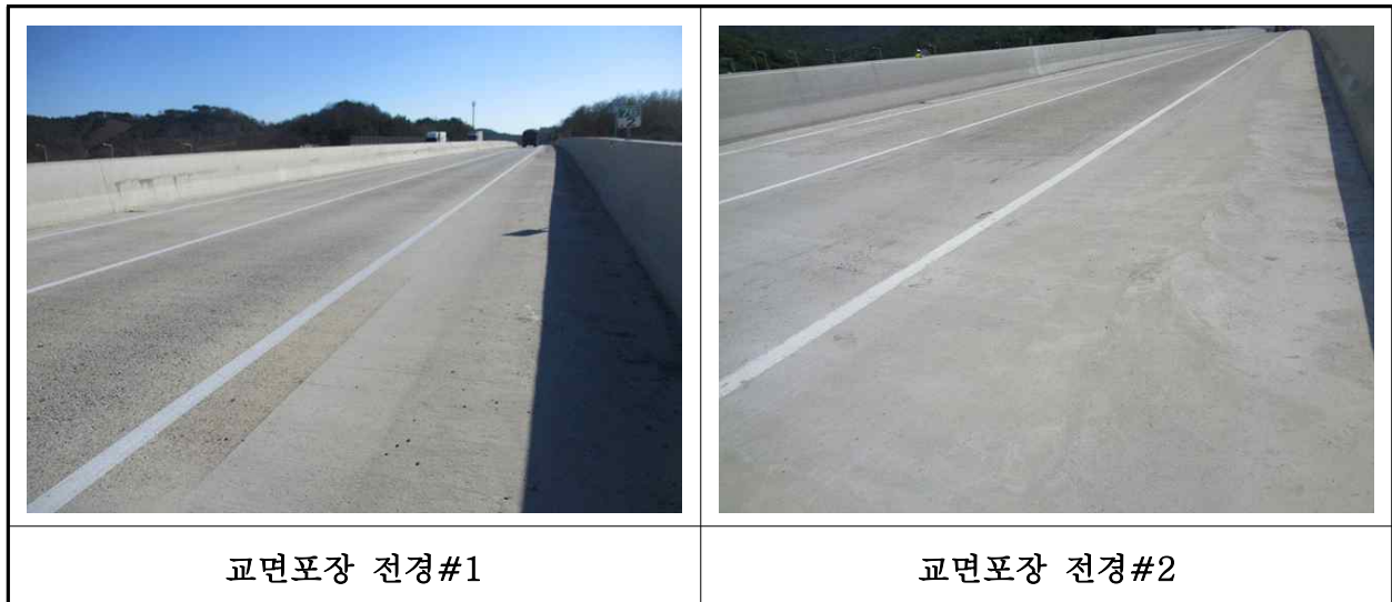
【사진 32.3.41】 교면포장 전경
