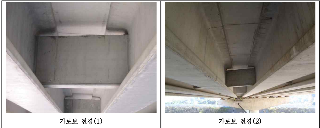
【사진 32.3.6】 가로보 전경
