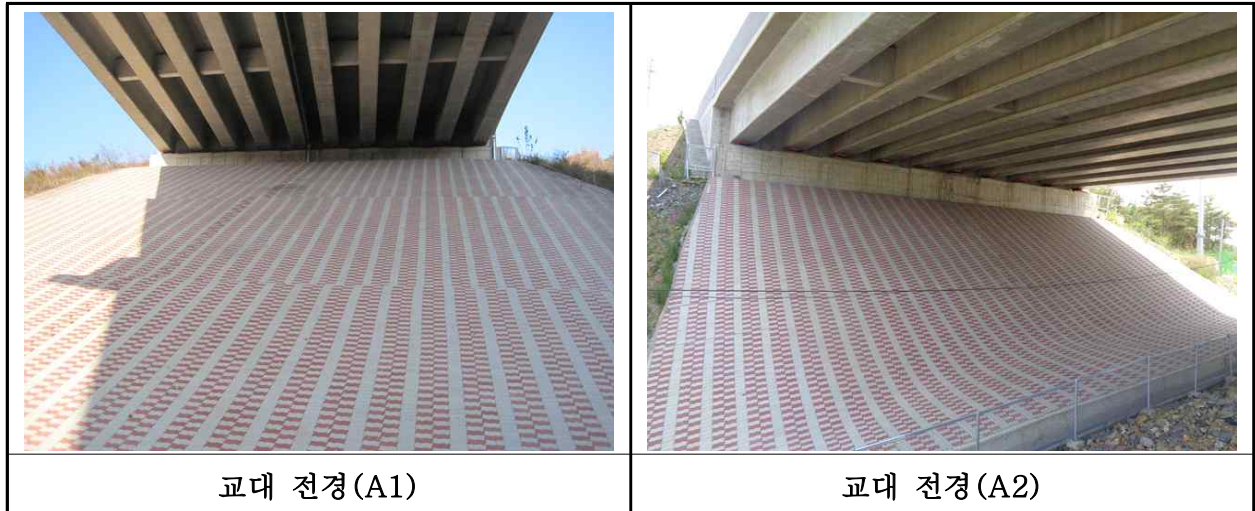
【사진 32.3.31】 교대 전경
