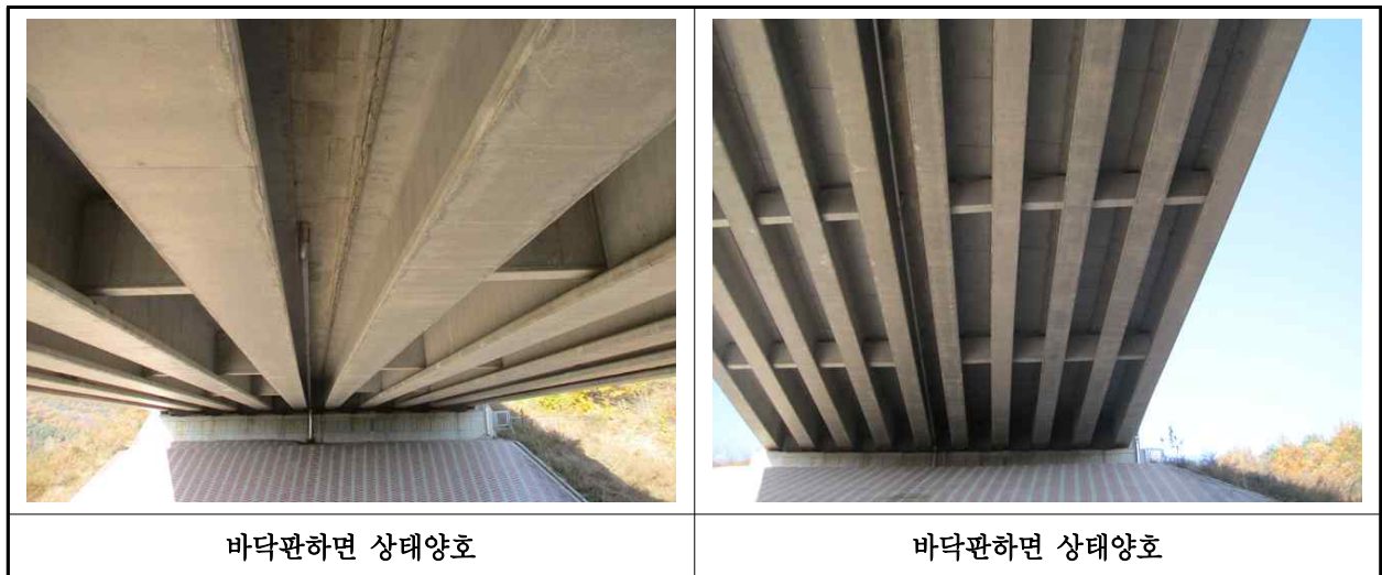
【사진 32.3.3】 바닥판하면 손상현황
