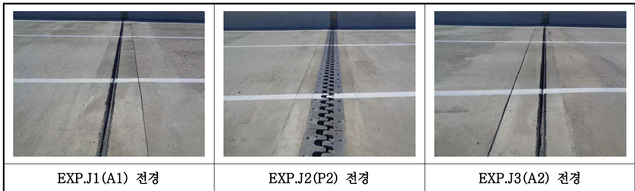
【사진 32.3.16】 신축이음장치 전경
