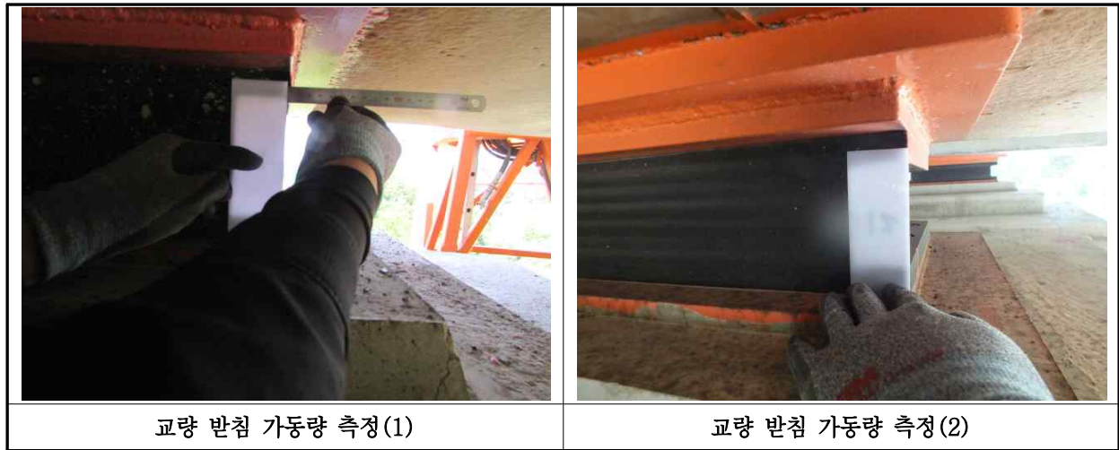
【사진 32.3.37】 교량받침 이동량 측정
