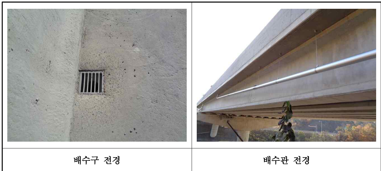
【사진 32.3.21】 배수시설 전경
