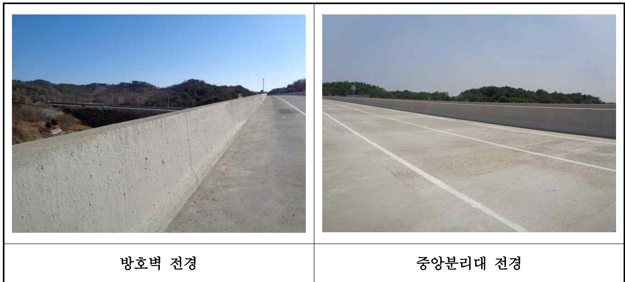
【사진 32.3.23】 방호벽 및 중앙분리대 전경
