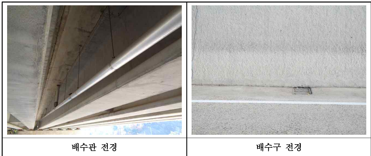
【사진 32.3.43】 배수시설 전경
