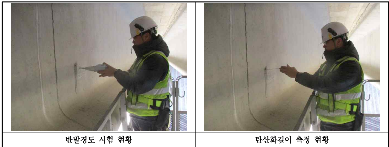
【사진 32.4.1】 콘크리트 내구성조사 현황
