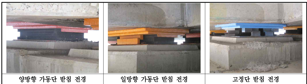
【사진 32.3.12】 교량받침 전경
